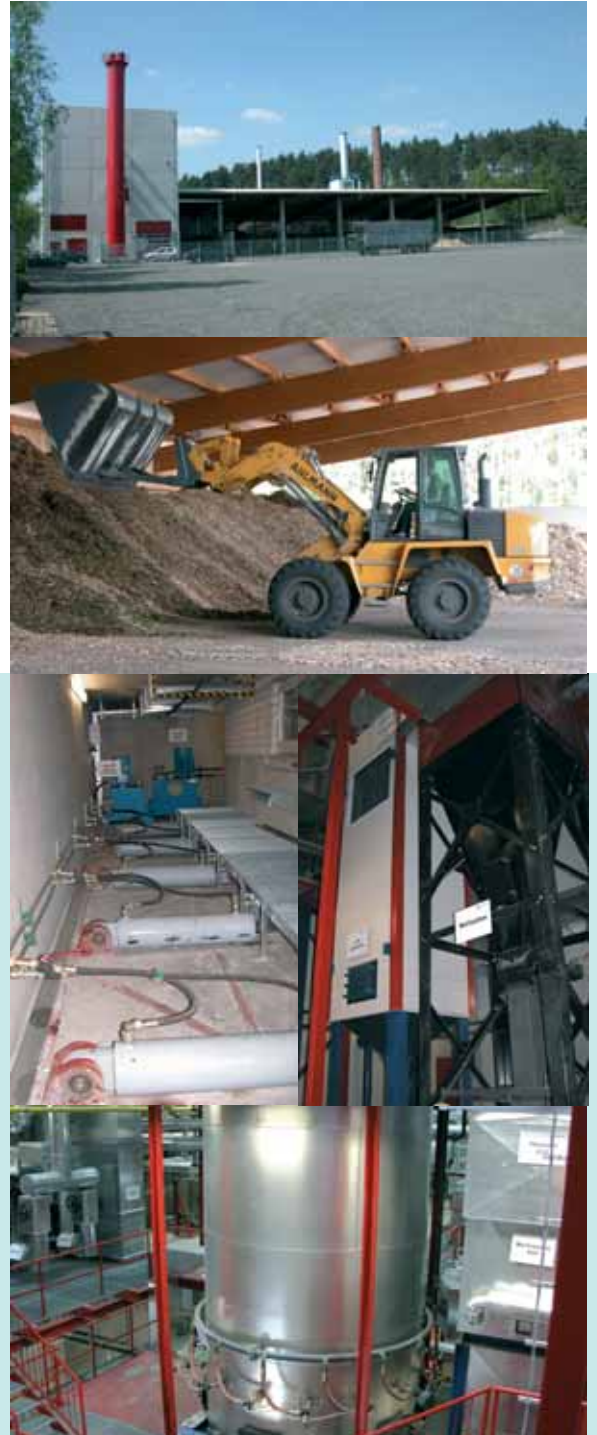
Gesamtansicht ORC-Holzheizkraftwerk, Holzlager, Schubboden mit Einzug, Luftvorwärmer und Multizyklon und Thermoölkessel (Bilder von oben nach unten)
