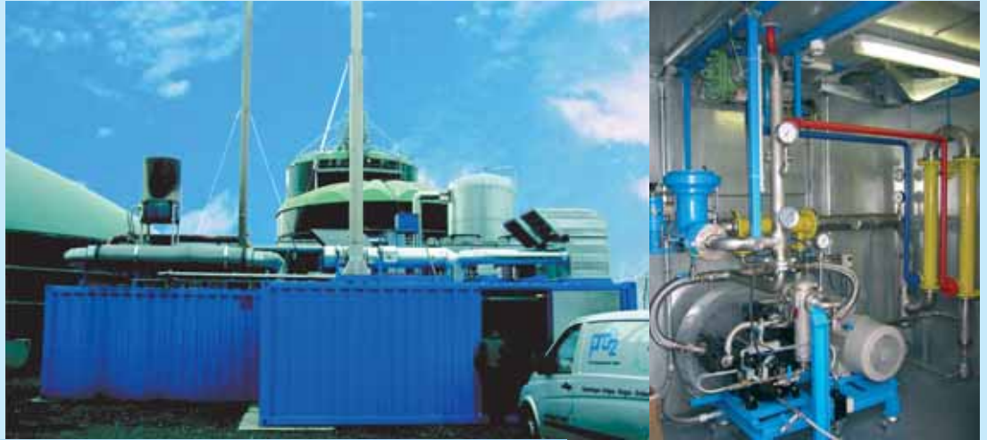
Container mit BHKW und Mikroturbine (Bild oben, links) und Blick auf die Mikroturbine (Bild oben rechts), Hof Loick, Lembeck
