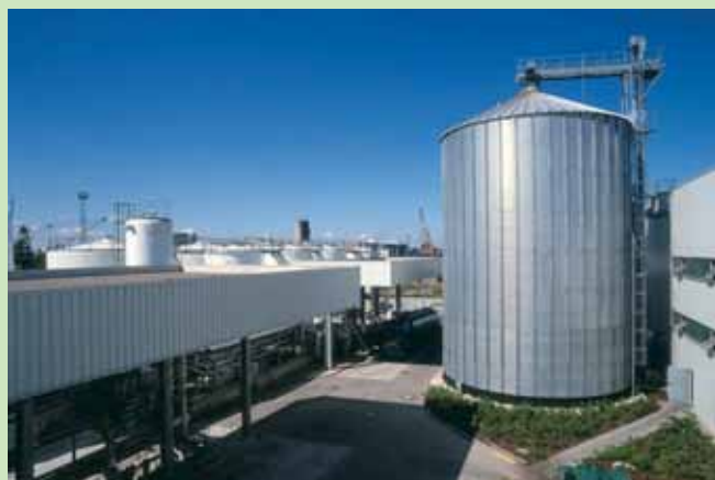
Raps-Silo mit 2000 m 3 Fassungsvermögen Foto: Degussa AG
